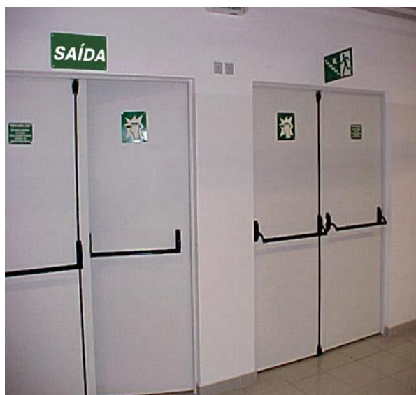
Figura 30 – Porta com barra antipânico
