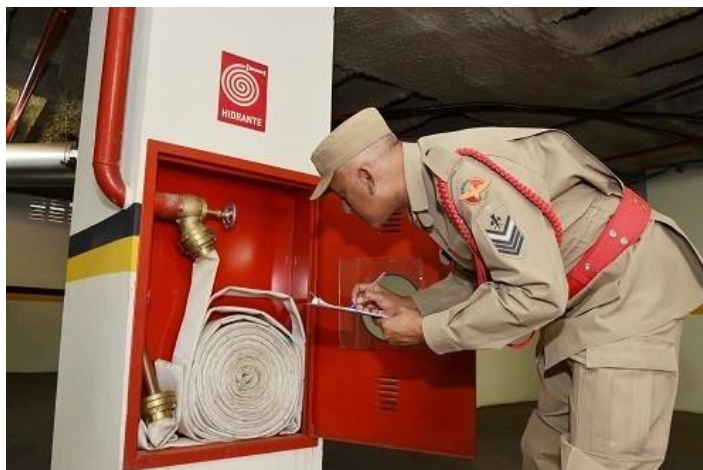
Figura 1 – Vistoria em Edificação para verificação das medidas de segurança contra incêndio e pânico.
