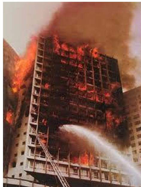
Edifício Joelma incendiado
