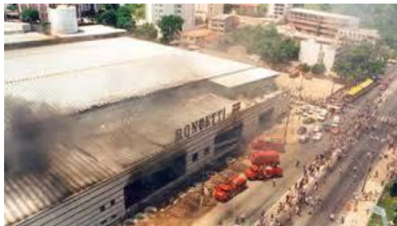
Figura 3 – Incêndio hipermercado Roncetti
