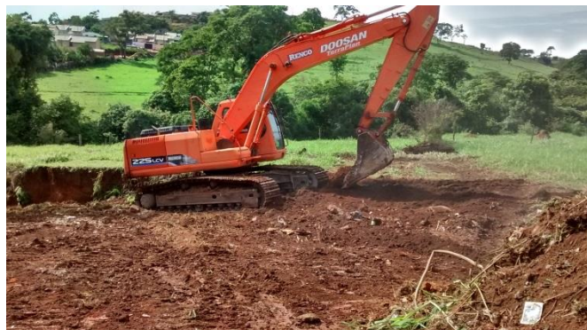
Figura 8. Uso de máquinas para reconformação
