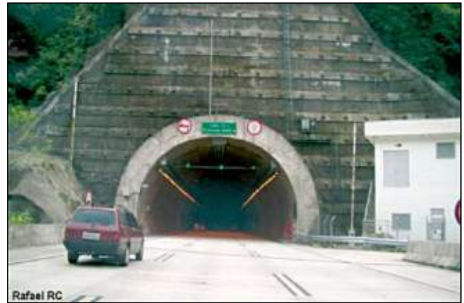
Figura 2 – Sinalização na entrada do túnel
