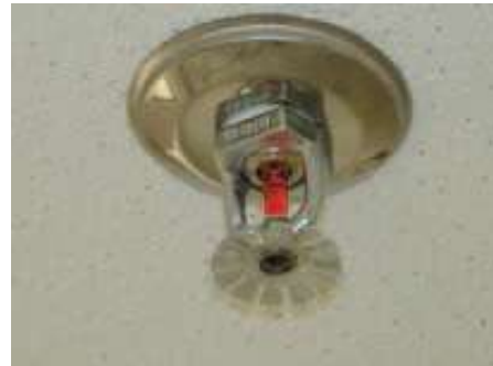
Figura 45 – Chuveiro automático
