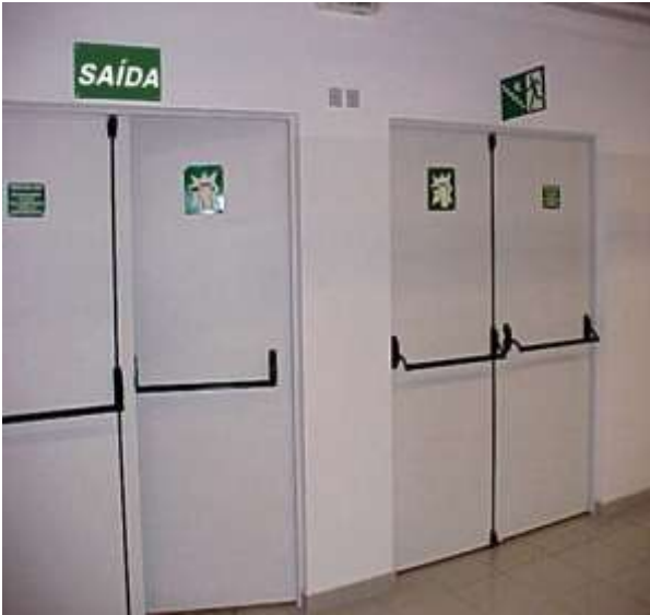
Figura 30 – Porta com barra antipânico
