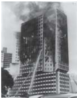
Figura 5 – Propagação por condução (contato direto das chamas)
