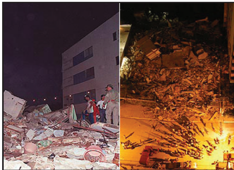
Figura 12.1 - Edifício Areia Branca na cidade do Recife/PE
