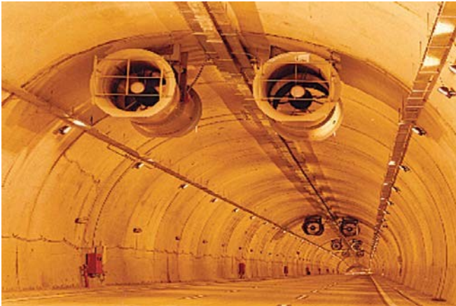
Figura 1 - Sistema de ventilação longitudinal
