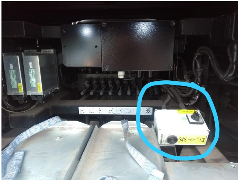
Foto 05 – Interruptor localizado na parte traseira da Auto Escada Fonte: Do Autor
